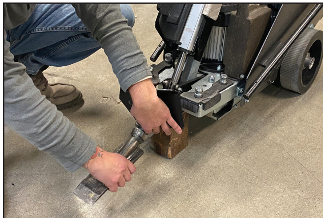
ブレードホルダーの取り付け。
