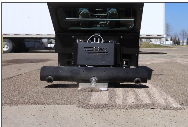
Machine schraapt epoxy-bedekt beton.
