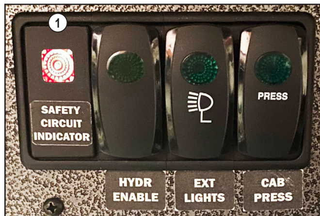
(1) Het lampje van het veiligheids-circuit brandt om aan te geven dat het hydraulische systeem is uitgeschakeld.
