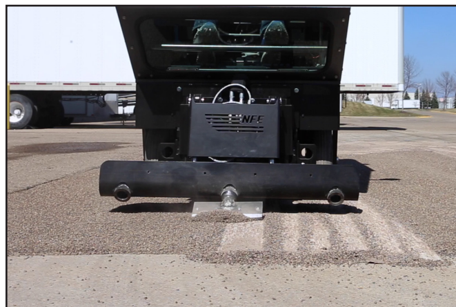
Machine grattant du béton recouvert d'époxy.
